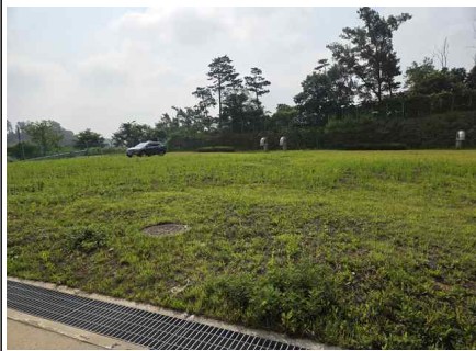
<배수지 상부 현황>
