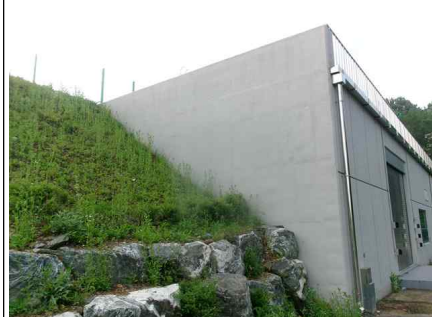
<유입밸브실 외부 양호>
