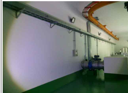
<유입밸브실 내부 벽체 양호>
