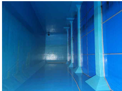
<배수지 2지 전경>
