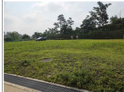
<배수지 상부 전경>
