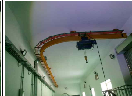
<유입밸브실 내부 상부슬래브 양호>
